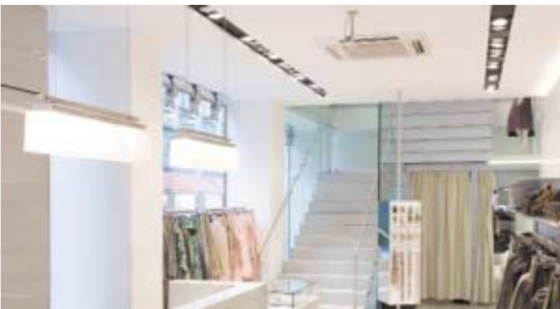
Fig. 1. Les solutions combinant des lampes aux halogénures métalliques et des alimentations électroniques s'imposent de plus en plus dans l'éclairage des espaces de vente (Shop lighting)
