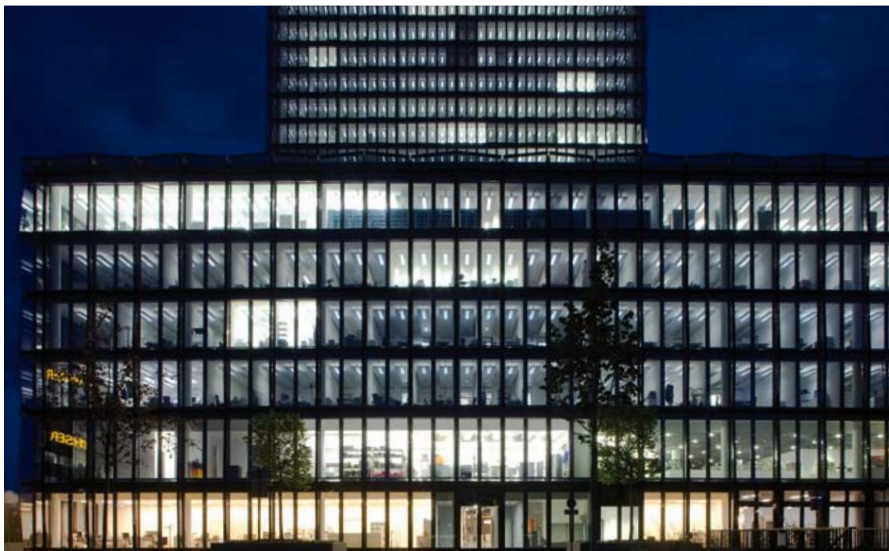
Fig. 1. Les installations d'éclairage basées sur DALI sont aussi nombreuses que diverses, allant du simple système de variation manuelle aux solutions en réseau capables d'assumer des tâches complexes
